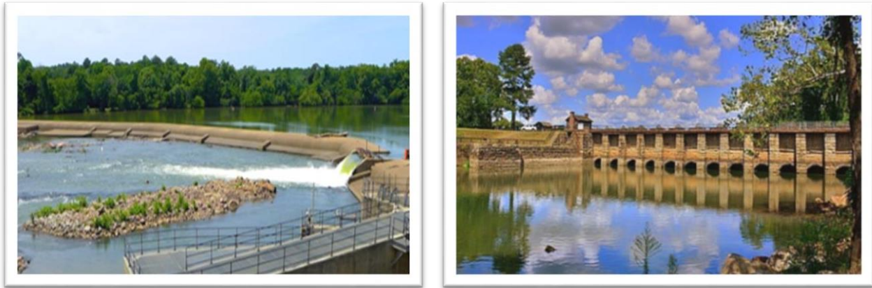
Figura 26. Dos vistas de las compuertas de cabecera
